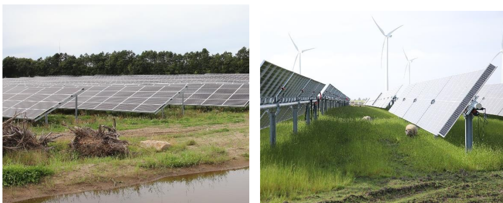
Figur 2.1: Solceller monteret på faste stativer (til venstre) og på bevægelige stativer, kaldt trackersystem (til højre).
